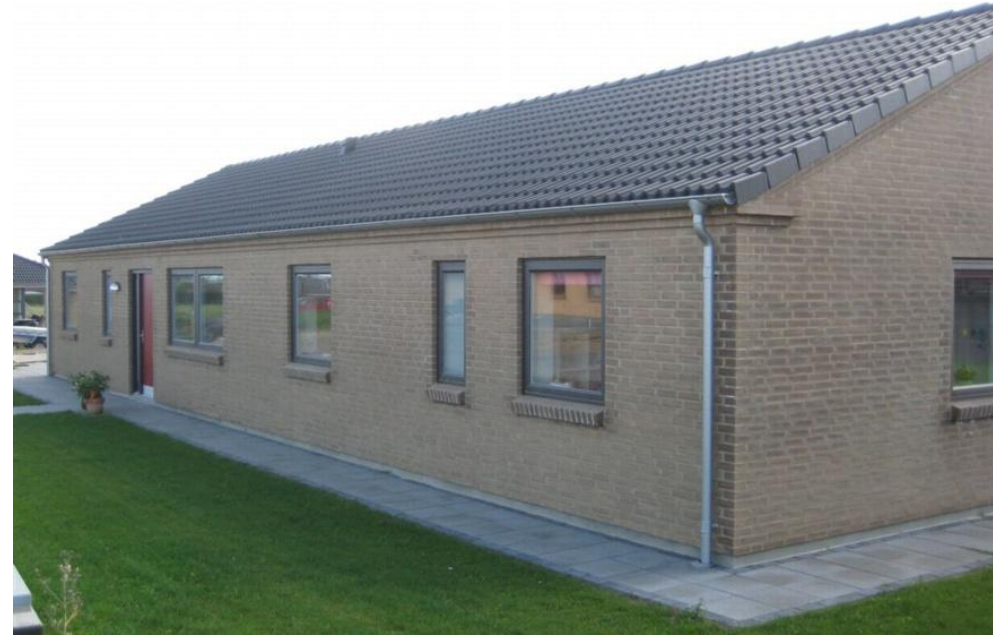
Huset bliver opført i samme stil.
